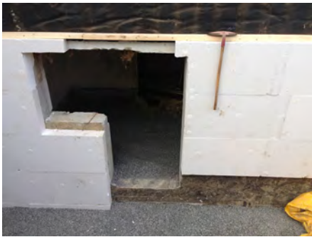
Ny inngang til kjeller
