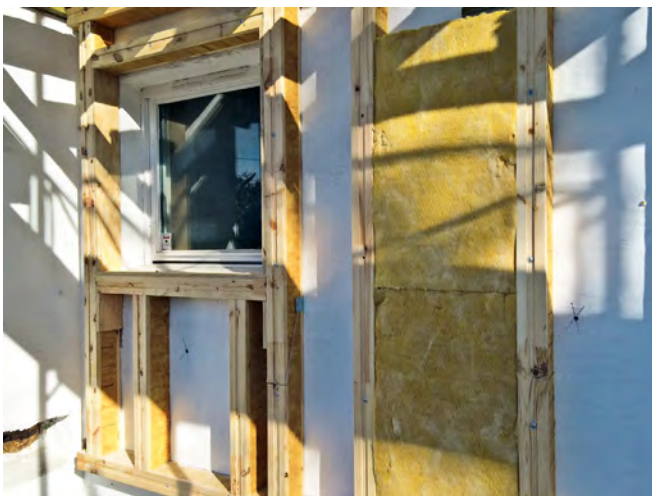
GLAVA Pluss system monteres på muren i sokkeletasjen.
