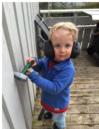
Sondre hjelper med riving av kledningen i huset på Hjelpestad.
