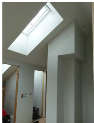
Innebygde ventilasjonskanaler i 2. etg
