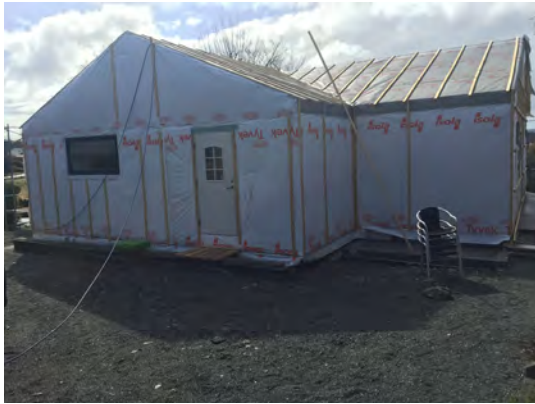
Kontinuerlig vindtetting for vegger og tak.
