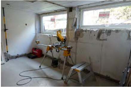
Nye vinduer i kjeller
