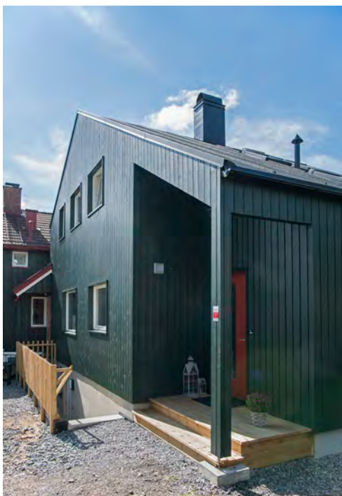
Nye fasader og nytt inngangsparti Foto: Jiri Havrand
